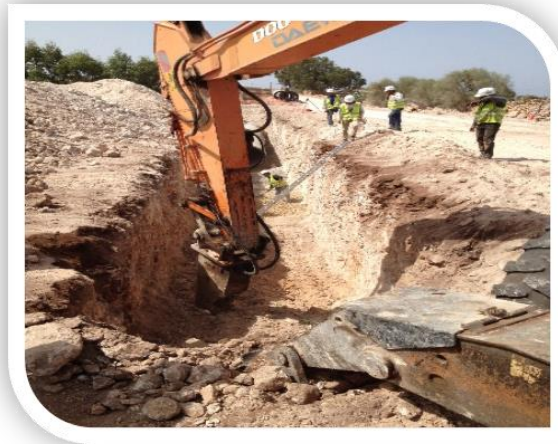
Chantier Azmmour Bir Jdid
