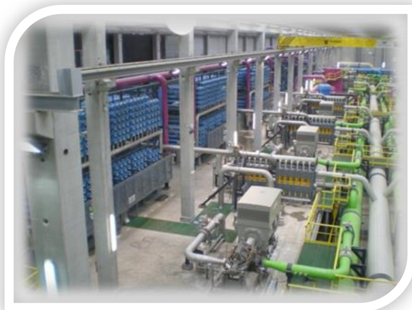
Site prévue pour l'unité de dessalement à Dakhla
