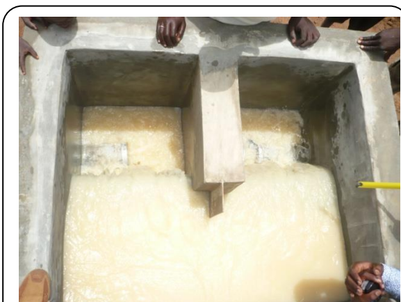
Photo n° 1 : bassin de répartition composé d'un bac d'arrivée et de deux bacs de dérivation
