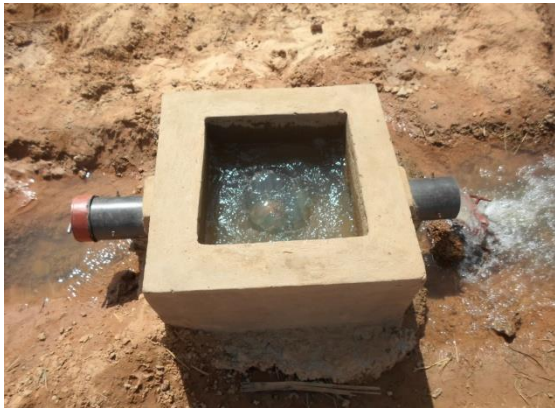
Photo n° 3 : ouvrage de prise doté d'une seule sortie au niveau du bac
