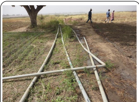
Photo n° 8 : multitude de conduites de refoulement privées pour le transport d'eau
