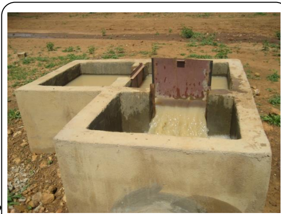
Photo n° 2 : autre forme de bassin de répartition
