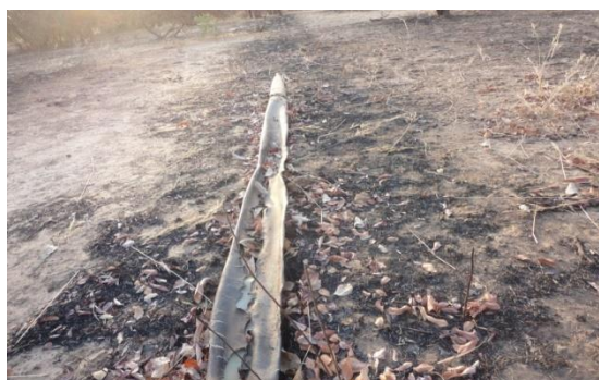
Photo n° 11 ; conduite de refoulement abîmée par les feux de brousse
