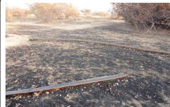
Photo n° 12 : conduites de distribution détériorées par les feux de brousse
