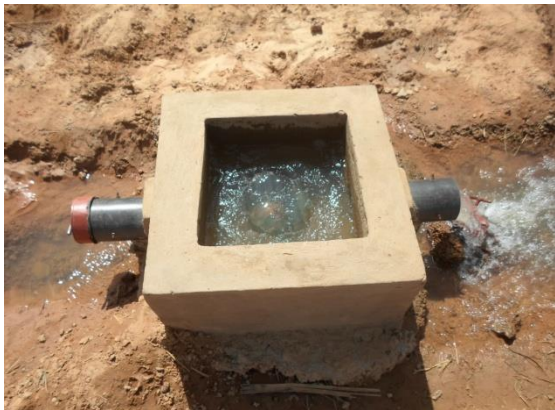
Photo n° 17 : ouvrage à une seule prise dans les sortie sont équipées de bouchons
