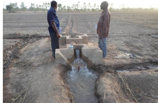
Photo n° 4 : ouvrage de prise sans bac et doté de deux sorties directes
