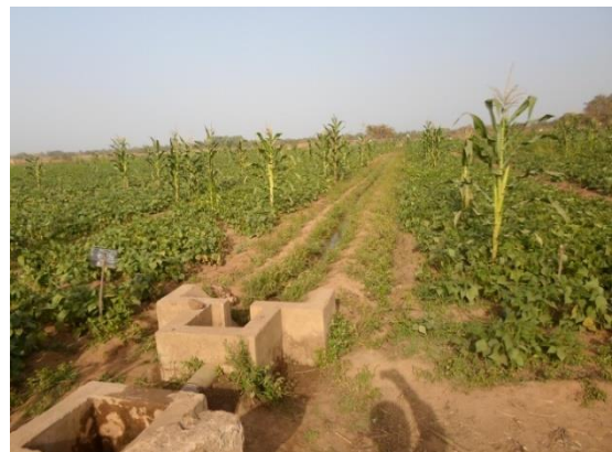
Photo n° 18 : ouvrage à deux prises
